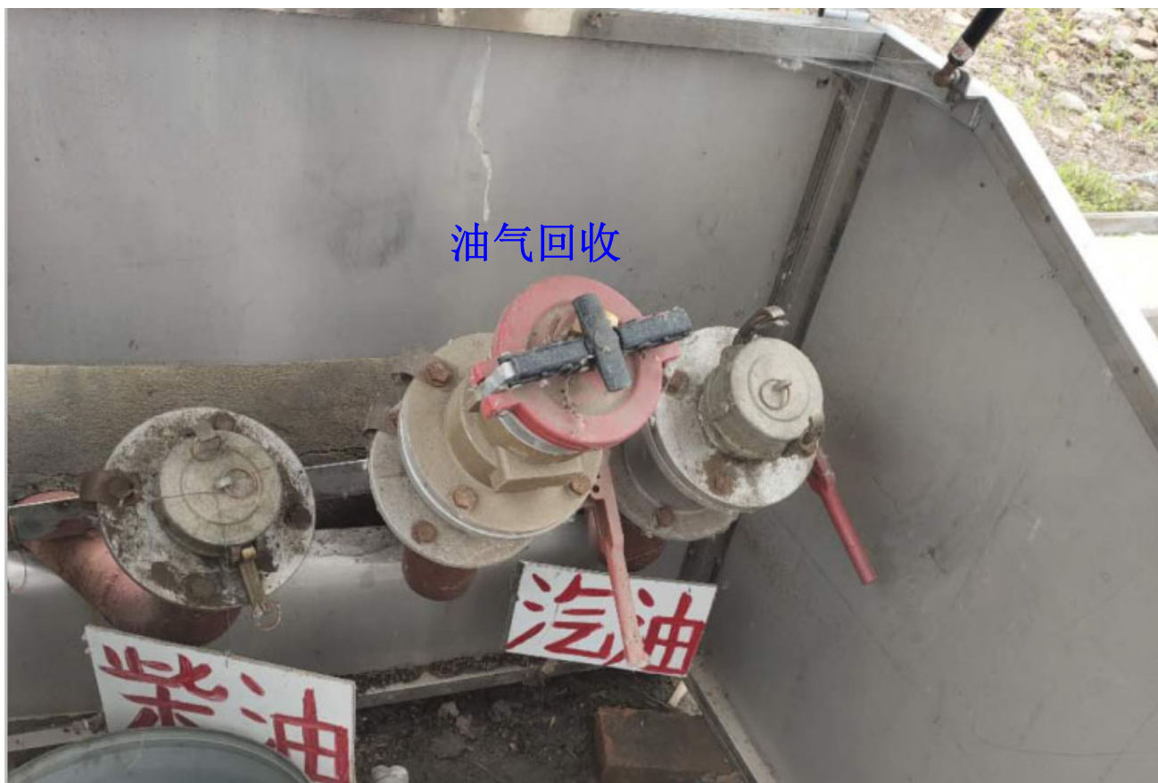
附图 3 一级油气回收系统（卸油油气回收）
